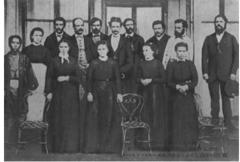
Photographie 2 - Le personnel français réuni autour de Paul Brunat au démarrage de l'usine
